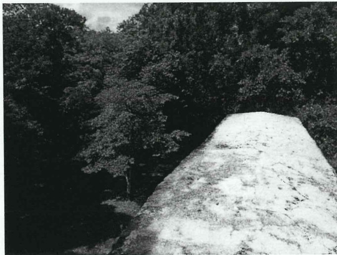
Foto 3. Techo del Edificio 389, Acrópolis Sur
